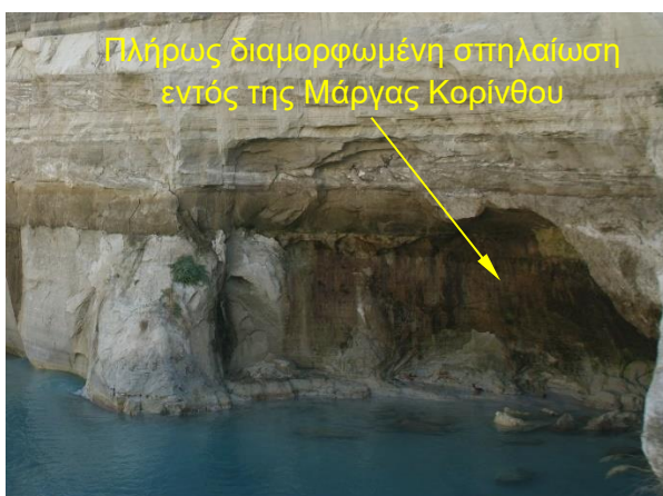
2γ. Περιοχή που έχει καταρρεύσει ο τοίχος ποδός και η διάβρωση της κατώτερης Μάργας Κορίνθου έχει προχωρήσει τόσο ώστε να πάρει τη μορφή πλήρους σπηλαιώσης.
